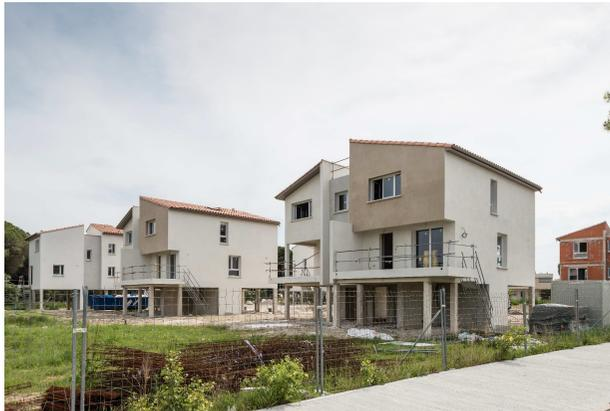
**PRINCIPE CONSTRUCTIF** : structure en béton (dalles et refends porteurs) associée à une façade en briques.
